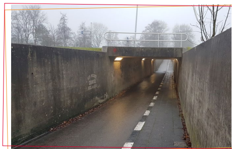
Figuur 3.7a: Het oorspronkelijke uiterlijk van de tunnel (bron auteur)
